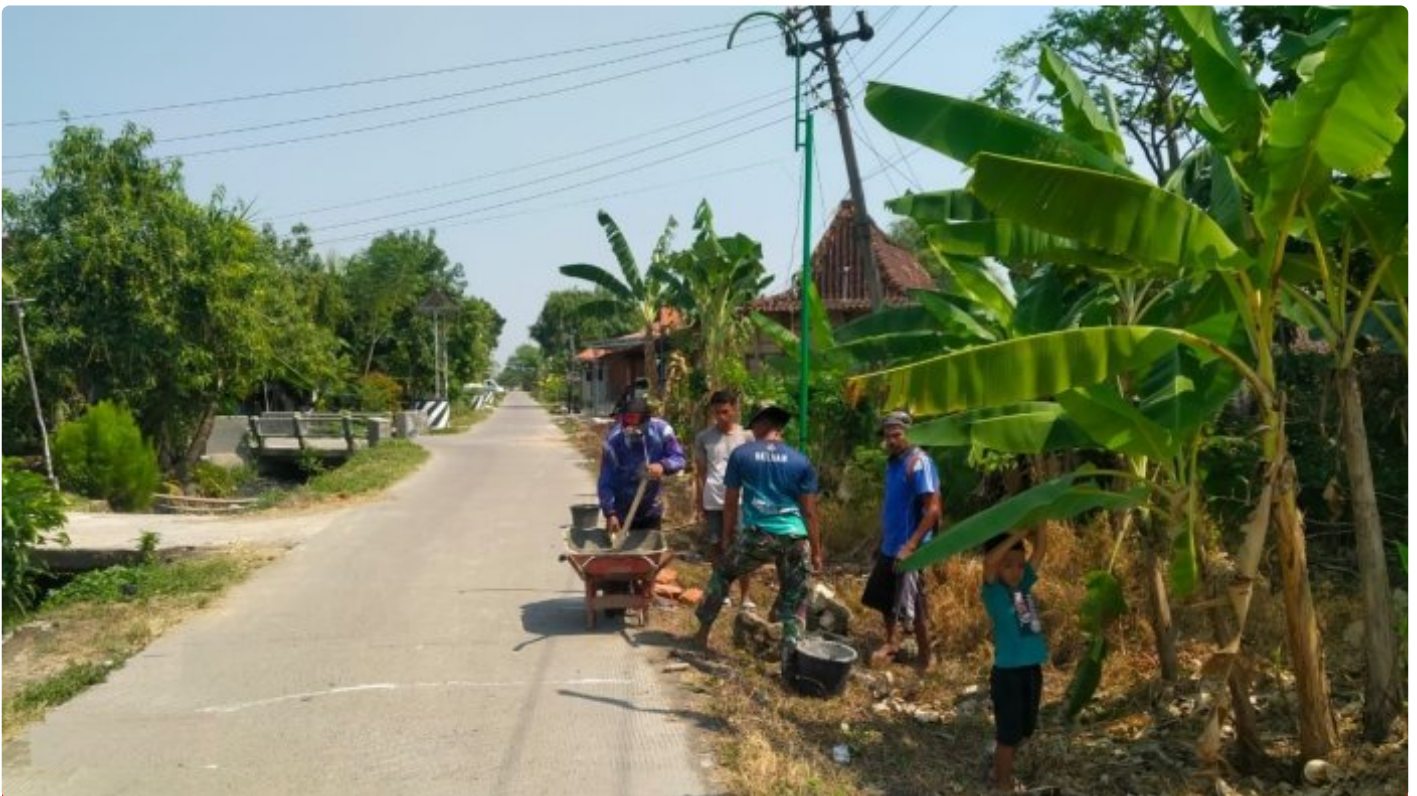
Satgas TMMD Reguler Ke-117 Kodim 0717/Grobogan Perbaiki Tiang Lampu Penerangan Jalan Di Desa Cangkring
