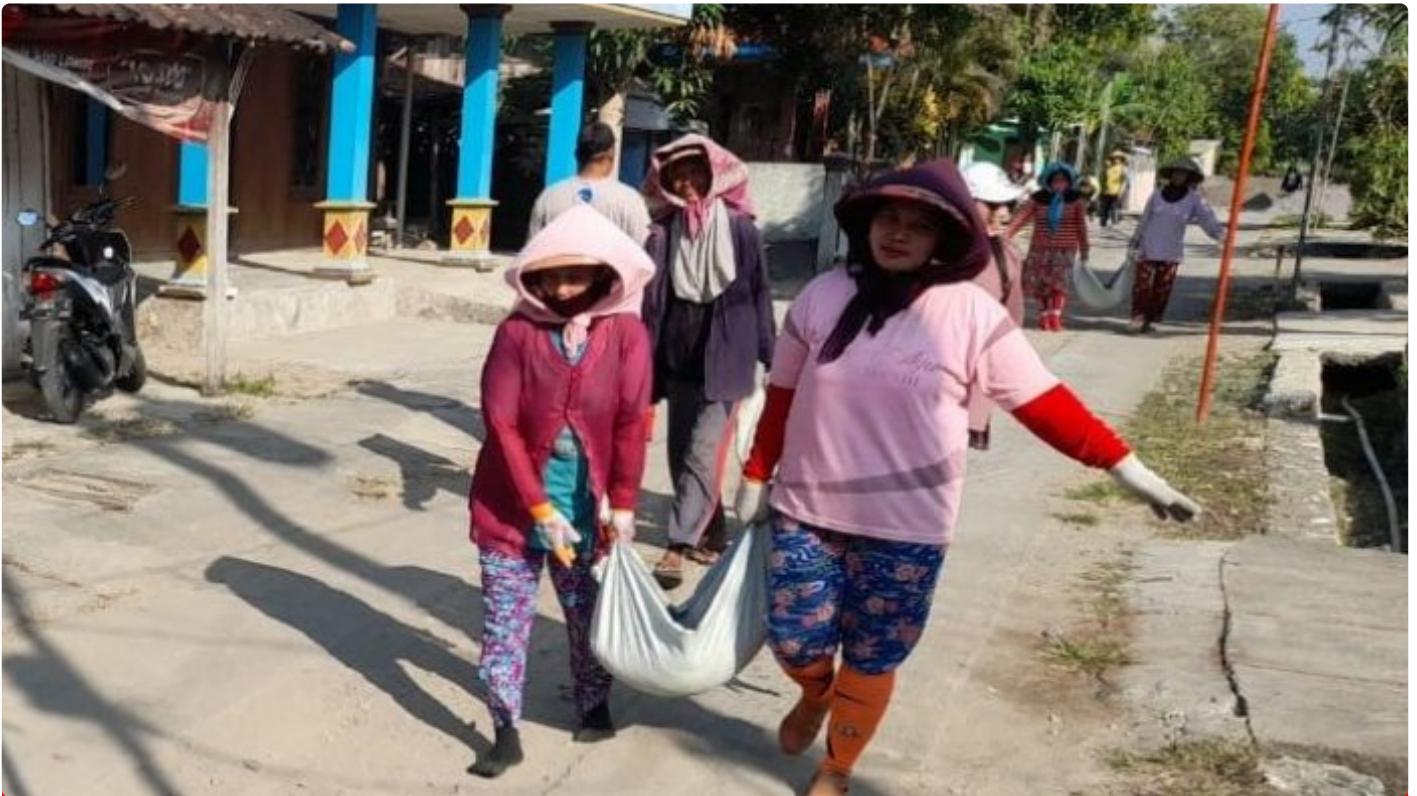
Ibu-Ibu Desa Cangkring Turut Membantu Pengecoran Jalan Program TMMD Ke-117
